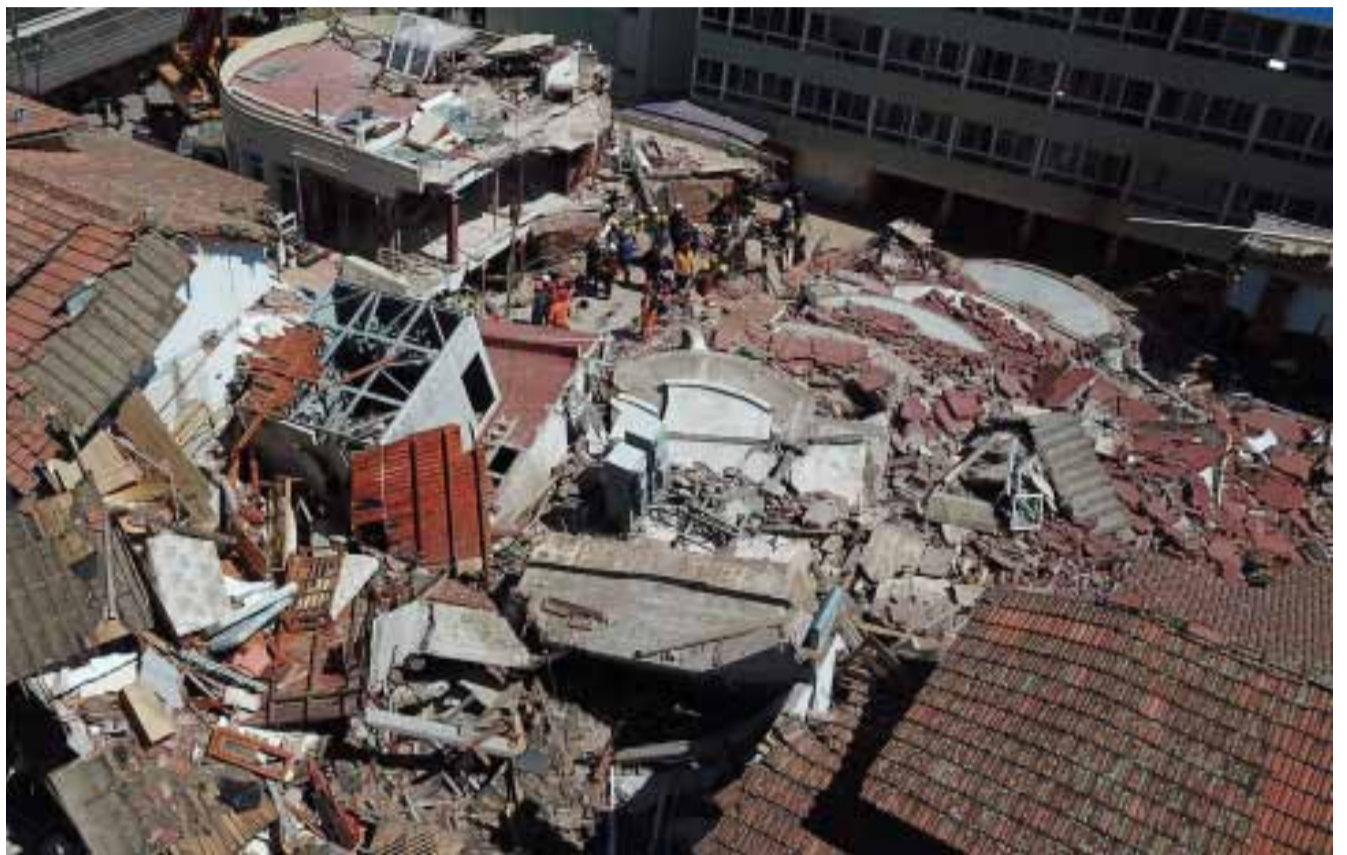
DERRUMBE DEL HOTEL EN VILLA GESELL
